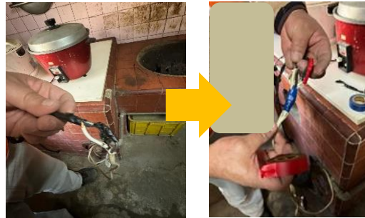
老舊電線重新纏線
