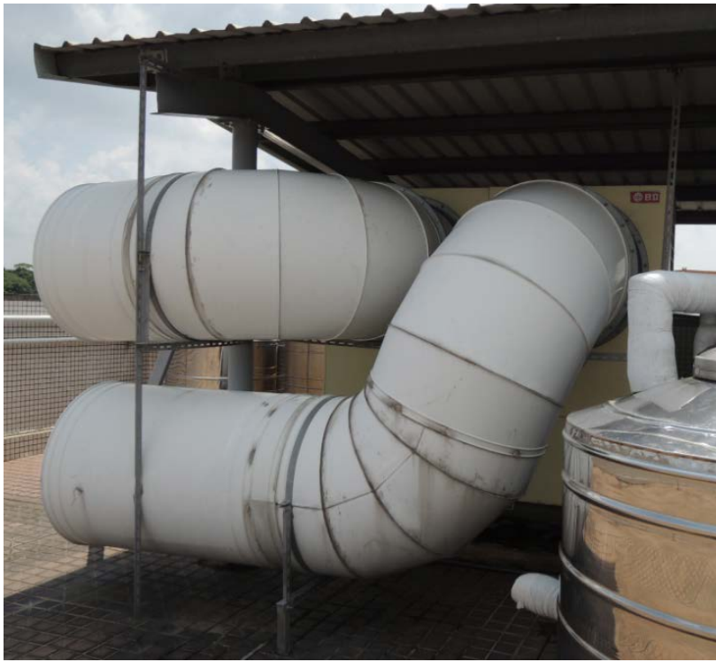
散熱導管裝設
