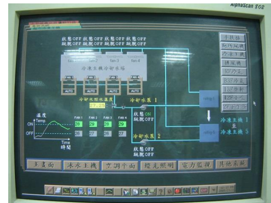
控制冷卻水塔冷卻水溫度及運轉台數，減少用電。(新竹SOGO)
