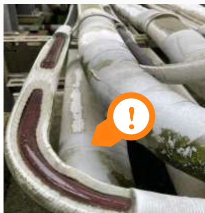
冷媒銅管保溫破損銅管外露
