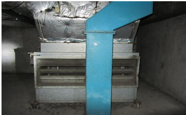
機房不堆雜物
